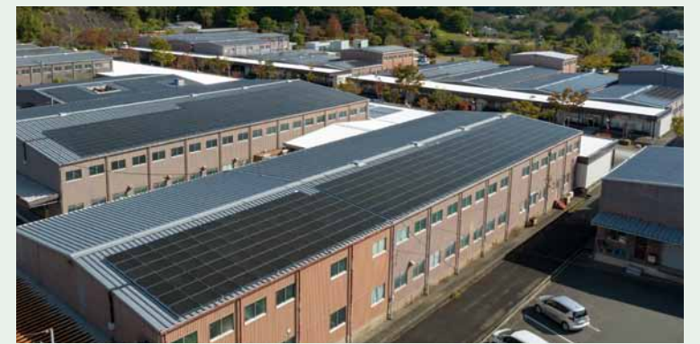
事業所の屋根に設置されたソーラーパネル
